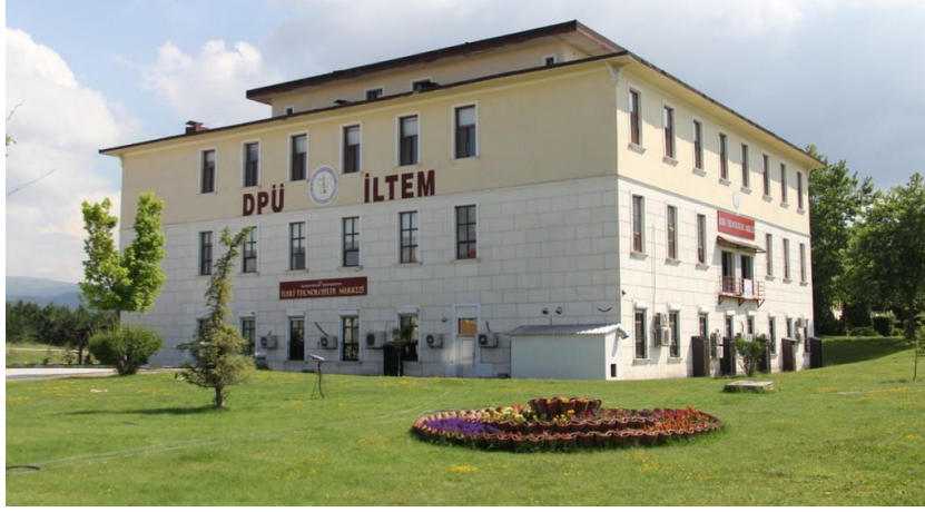
Şekil 30 Kütahya Dumlupınar Üniversitesi İleri Teknolojiler Tasarım Araştırma Geliştirme ve Uygulama Merkezi (İLTEM) Binası
