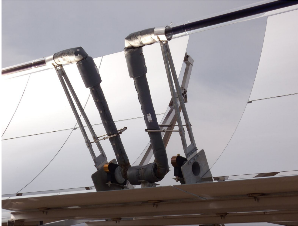
Şekil 52. Soğurucu boruların parabolik toplayıcı üzerindeki konumu (Anonim, 2011)
