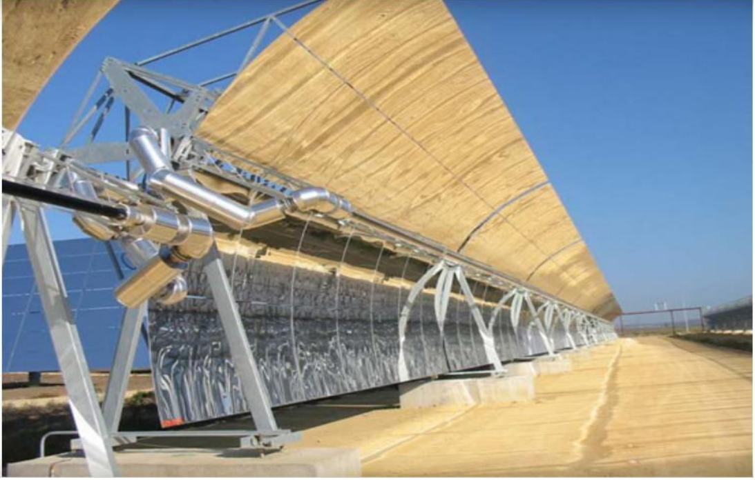
Şekil 34. CSP'lerde kullanılan parabolik yansıtıcı ve toplayıcı (Anonim, 2011k)
