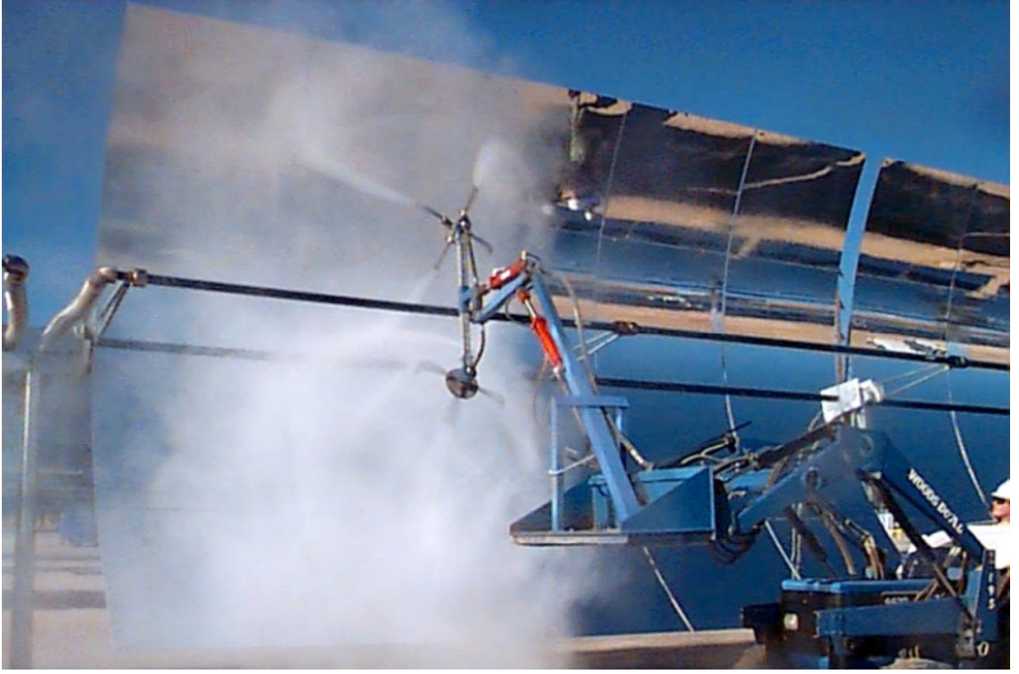
Şekil 38. Kramer Junction'da parabolik oluk toplayıcıların temizlenmesi (Anonim, 2011k)
