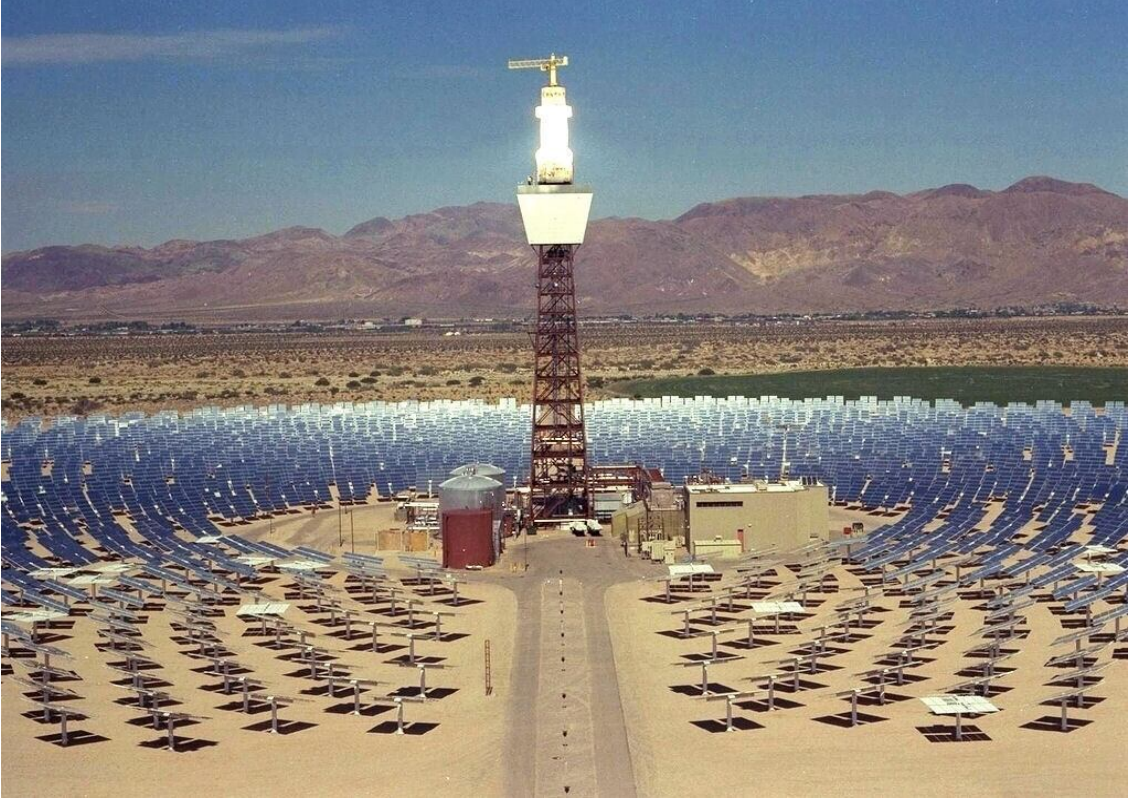
Şekil 40. Kule tipi CSP santrali ve heliostatlar (Anonim, 2011k)
