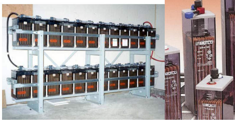
Şekil 90. PV sistemlerinde kullanılan akü ve akü grubu.
