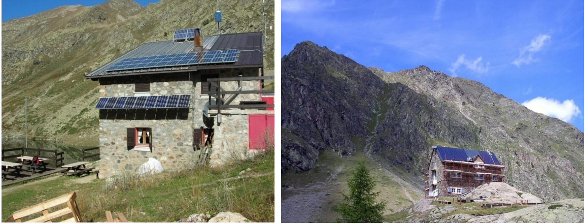
Şekil 66. Eysel bağımsız fotovoltaik güç sistemleri (Anonim, 2011s)
