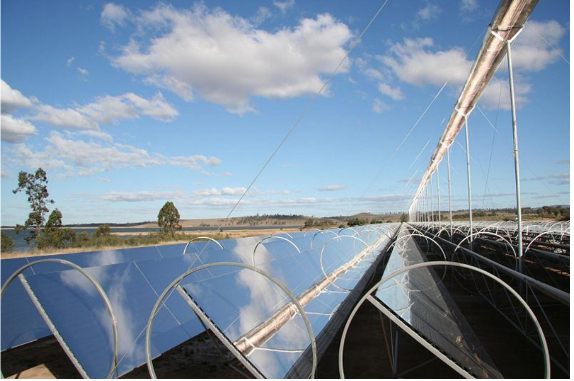
Şekil 44. Fresnel toplayıcılar ve odaklarında yer alan soğurucu (Anonim, 2011k)
