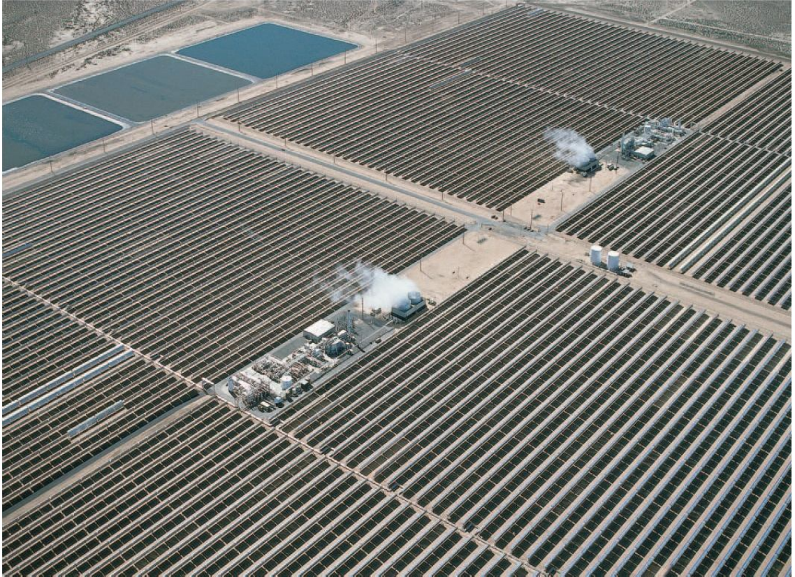
Şekil 35. ABD Nevada Solar One CSP santrali (Anonim, 2011k)
