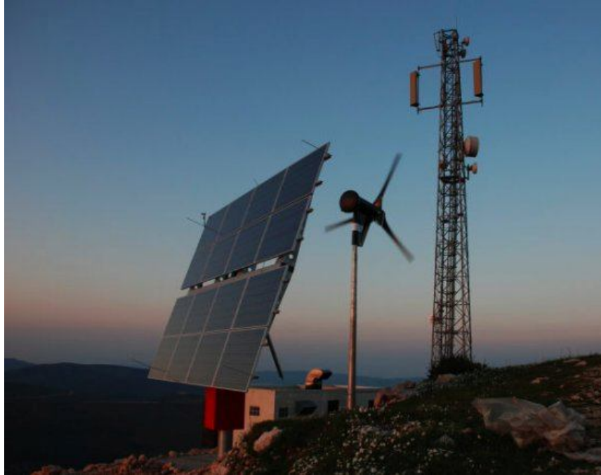
Şekil 104. Güneş izleyicisi sistemi ile destekli, yenilenebilir enerji ile çalışan ilk baz istasyonu (İzmir'in Çeşme ilçesi)
