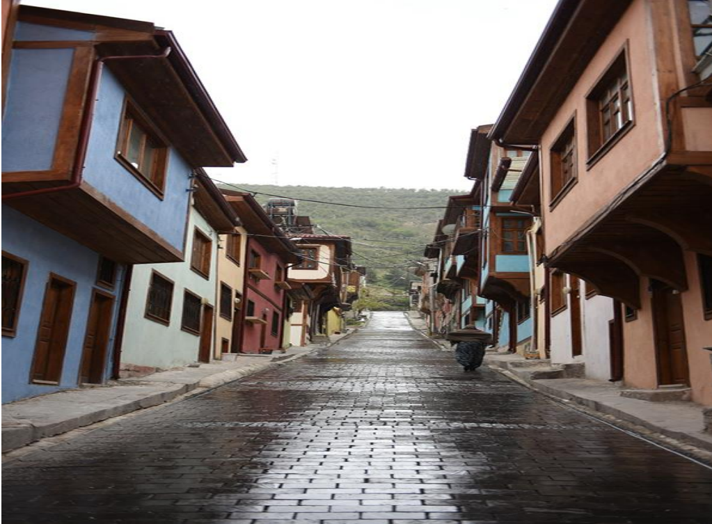
Şekil 89: Afyon Restorasyon Çalışmaları
