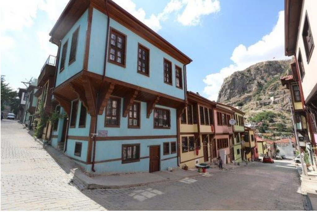
Şekil 88: Afyon Restorasyon Çalışmaları
