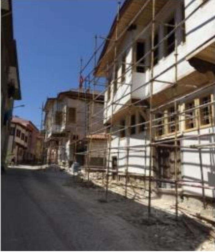
Şekil 84: Tokat 22. Sokak Restorasyon Çalışmaları
