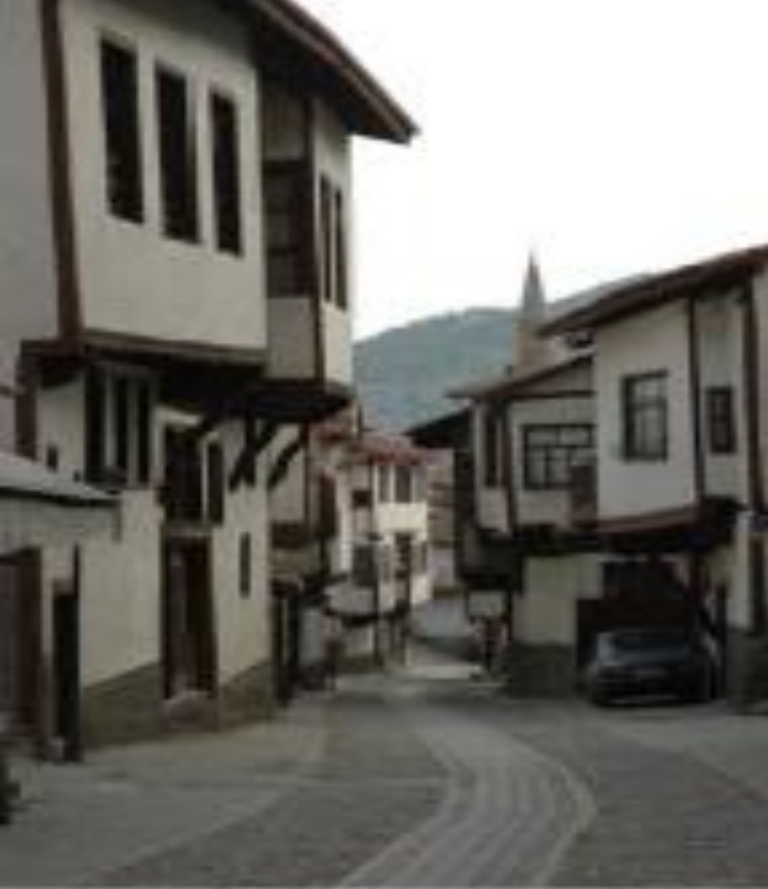
Şekil 85: Sokak Sağlıklaştırma Çalışmaları
