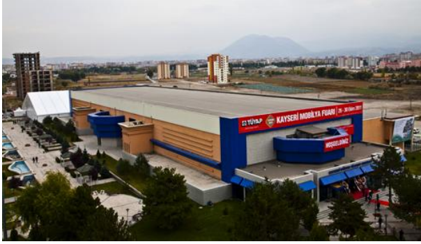
Şekil 5.1.1. Kayseri Fuar Alanı’nın Genel Görünüşü
