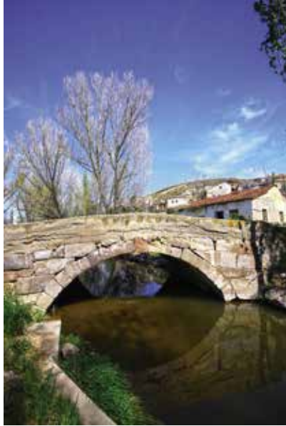
GÖMEÇ KÖPRÜSÜ, KOCASINAN
