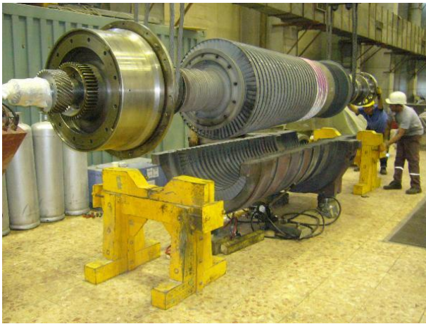
Şekil 42. Türbin İç Gövde Rotor Montajı
