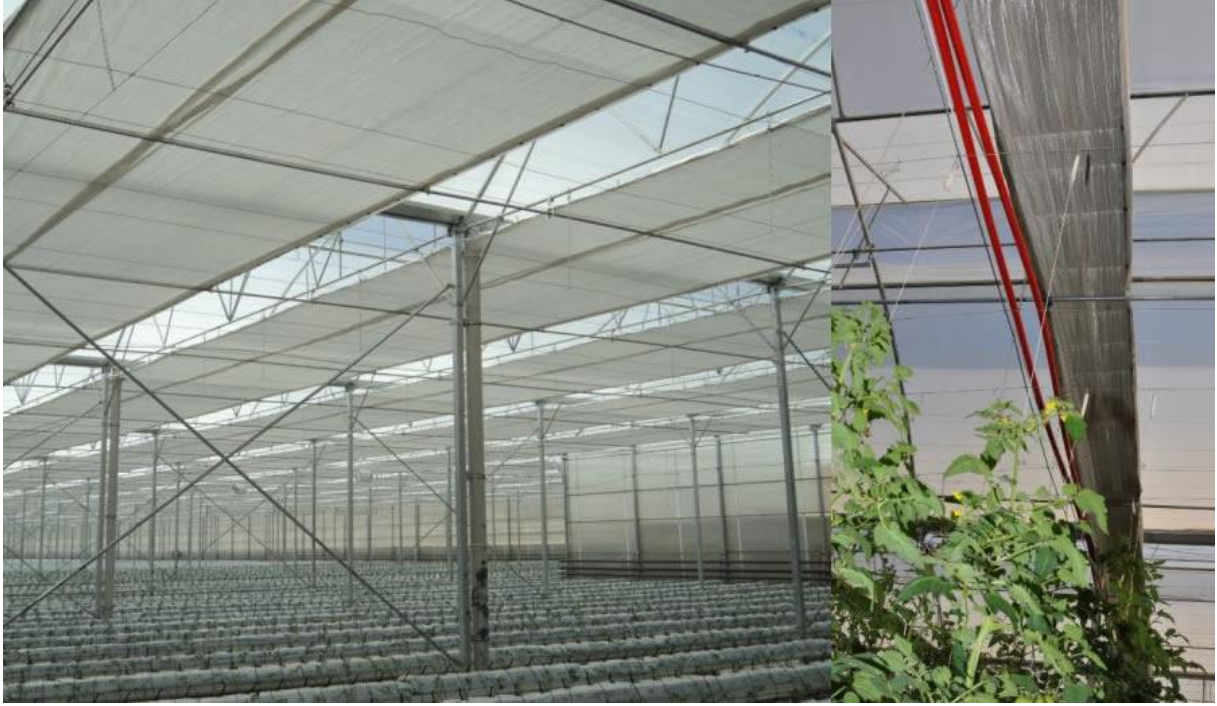
Resim 7.6. Isı Perdeleri Açık ve Kapalı Hali
