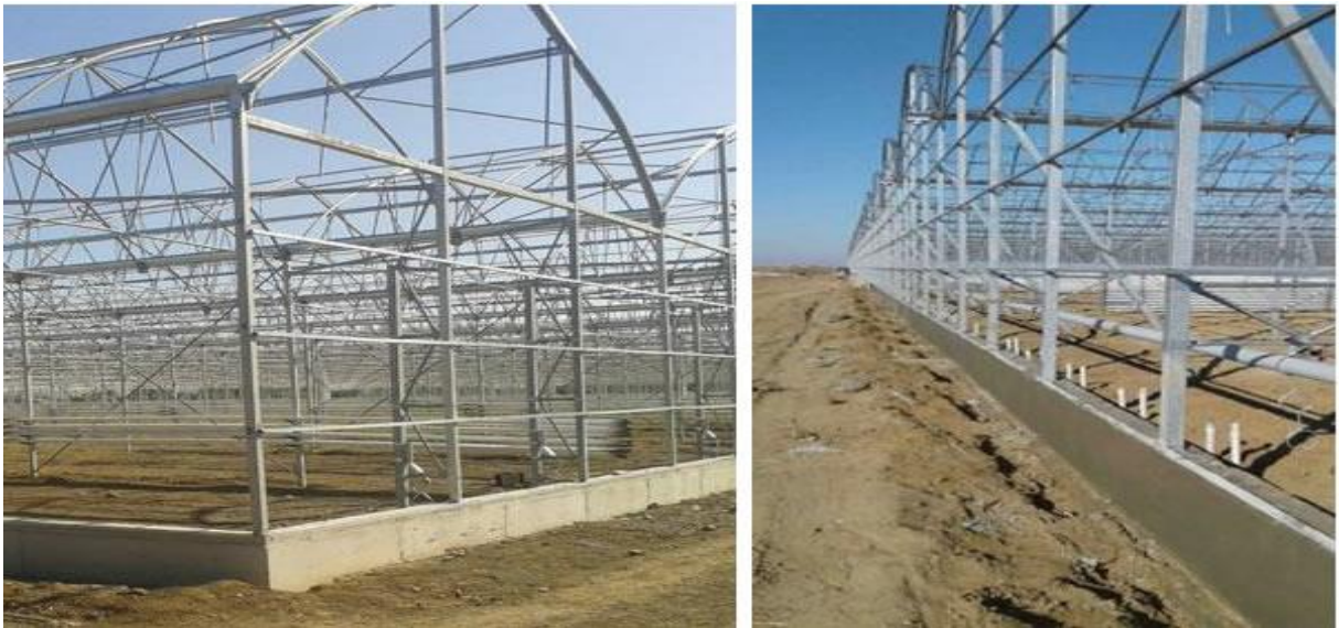
Resim 7.3. Çevre Temel ve Yan Perde Betonu
