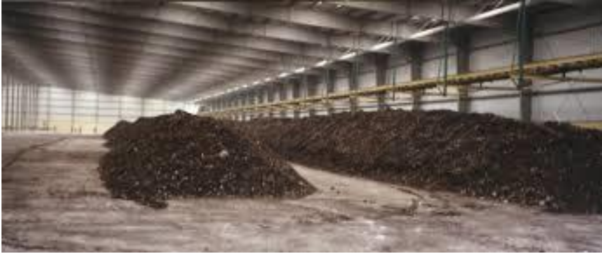
Şekil 4.66. Kompost Gübre Tesisi
