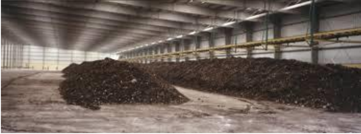
Şekil 4.24. Kompost Gübre Tesisi
