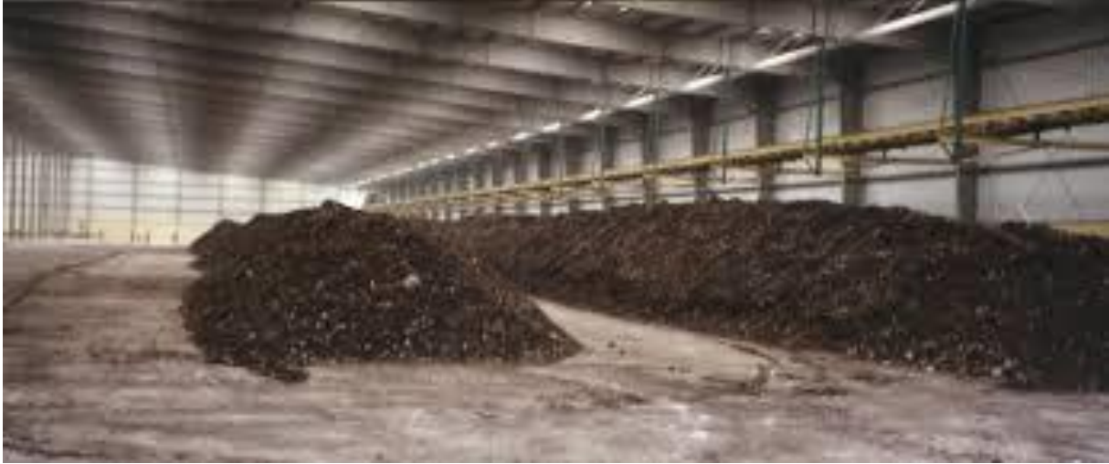
Şekil 4.31. Kompost Gübre Tesisi
