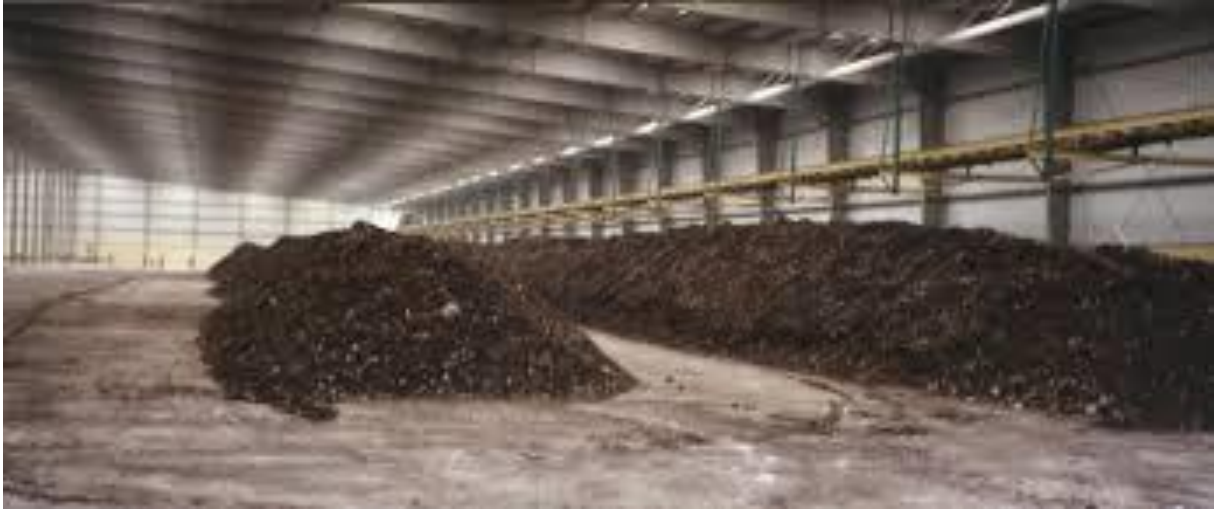
Şekil 4.99. Kompost Gübre Tesisi
