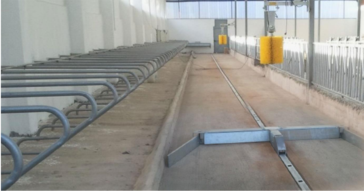
Resim 3.8 Modern Ahırlarda Zemin Temizliği İçin Sıyırıcı Sistem
