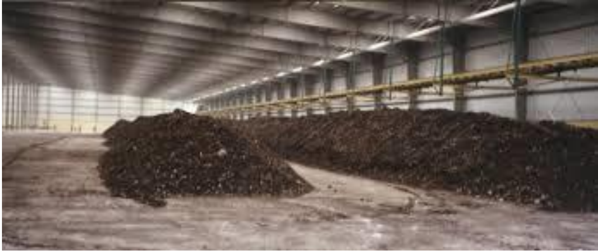
Şekil 4.80. Kompost Gübre Tesisi
