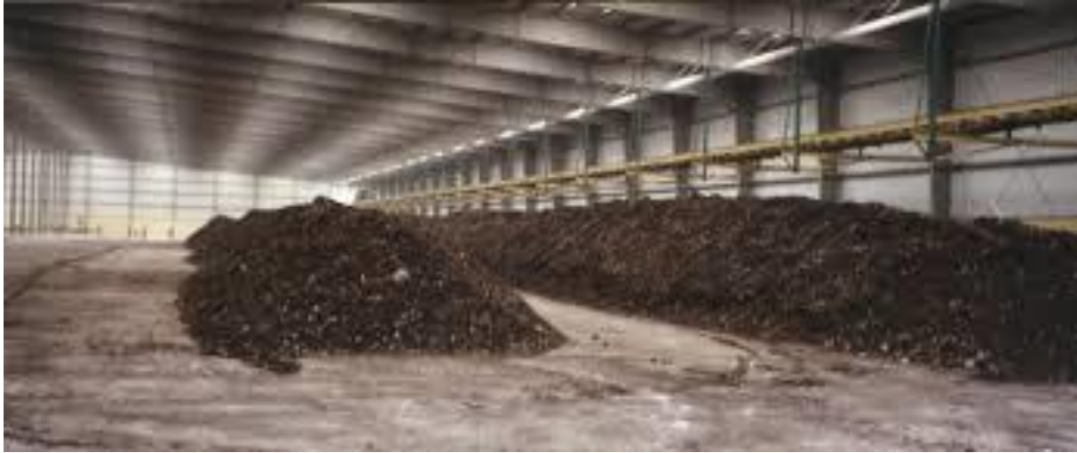
Şekil 4.93. Kompost Gübre Tesisi
