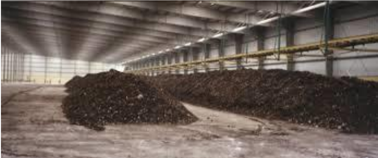
Şekil 4.10. Kompost Gübre Tesisi
