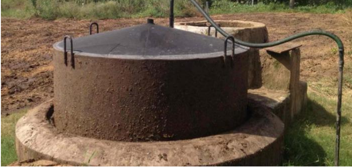
Şekil 4.106. Hareketli Kubbeli Biyogaz Tesisi Tasarımı
