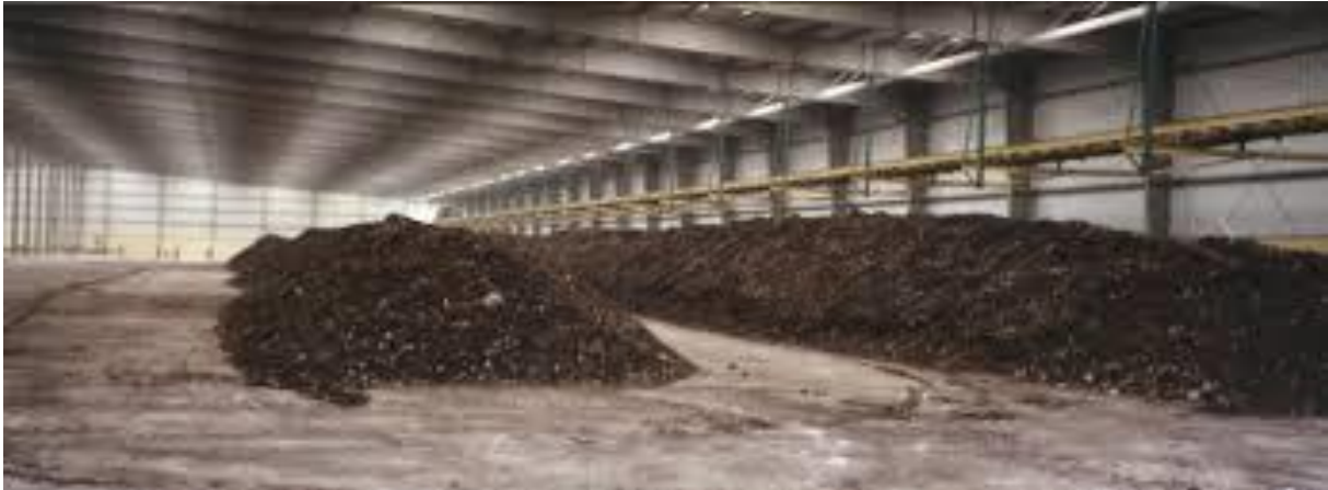
Şekil 4.86. Kompost Gübre Tesisi
