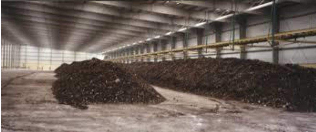
Şekil 4.38. Kompost Gübre Tesisi
