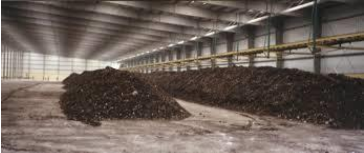
Şekil 4.59. Kompost Gübre Tesisi
