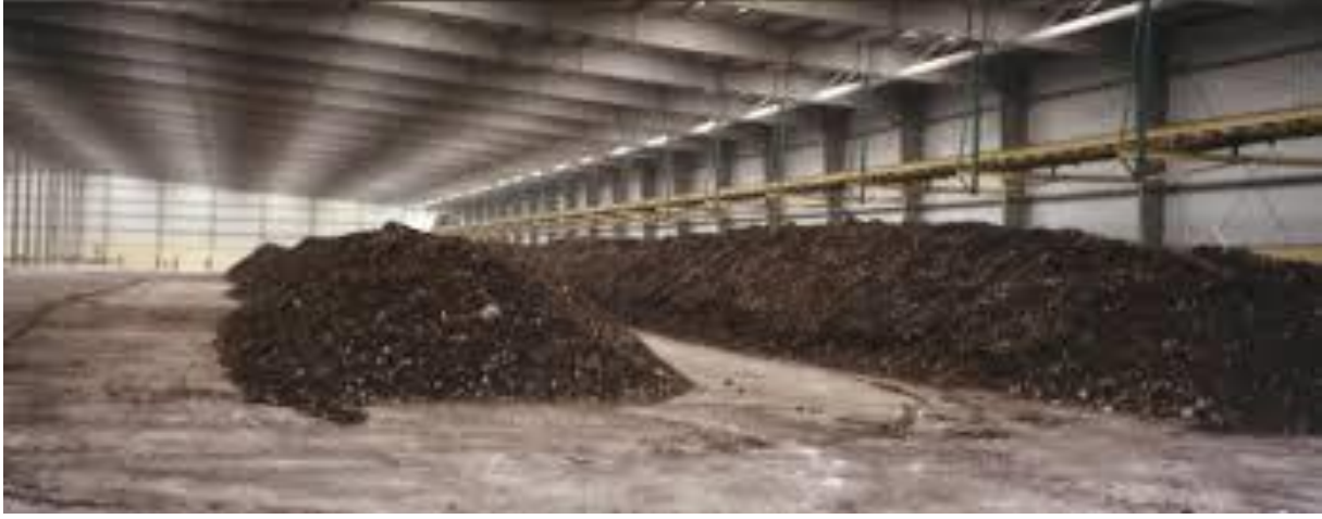
Şekil 4.73. Kompost Gübre Tesisi
