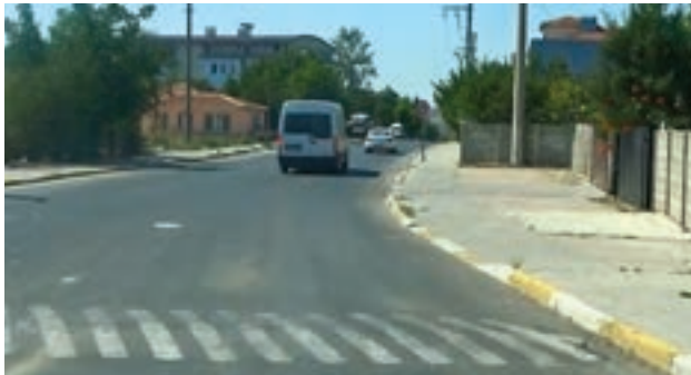
Fotoğraf 97 Sakızlıköy Caddesi'nde yol platformu üzerine yerleştirilen hız kesici tümsekler, Lüleburgaz (EMBARQ Türkiye, 2015)
