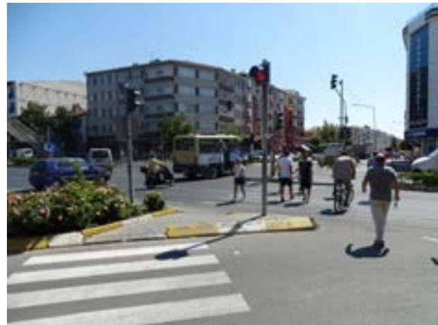
Fotoğraf 84 İstasyon Caddesi üzerinden D-100 Karayolu'nun Edirne istikametindeki trafik akımı için inşa edilmiş flaşör kontrollü tali yol (EMBARQ Türkiye, 2015)
