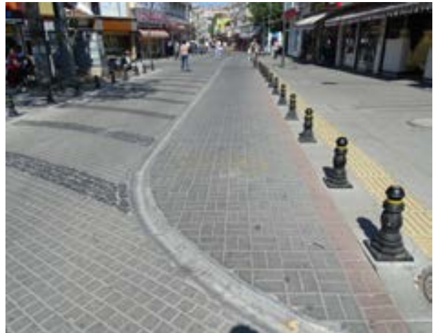
Fotoğraf 77 Bisiklet yolu üzerinde görünürlüğünü yitirmiş yatay işaretleme örneği (EMBARQ Türkiye, 2015)
