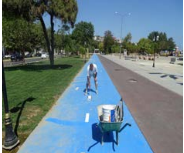
Fotoğraf 11 Bisiklet yolu üzerinde yatay işaretleme çalışmaları (EMBARQ Türkiye, 2015)
