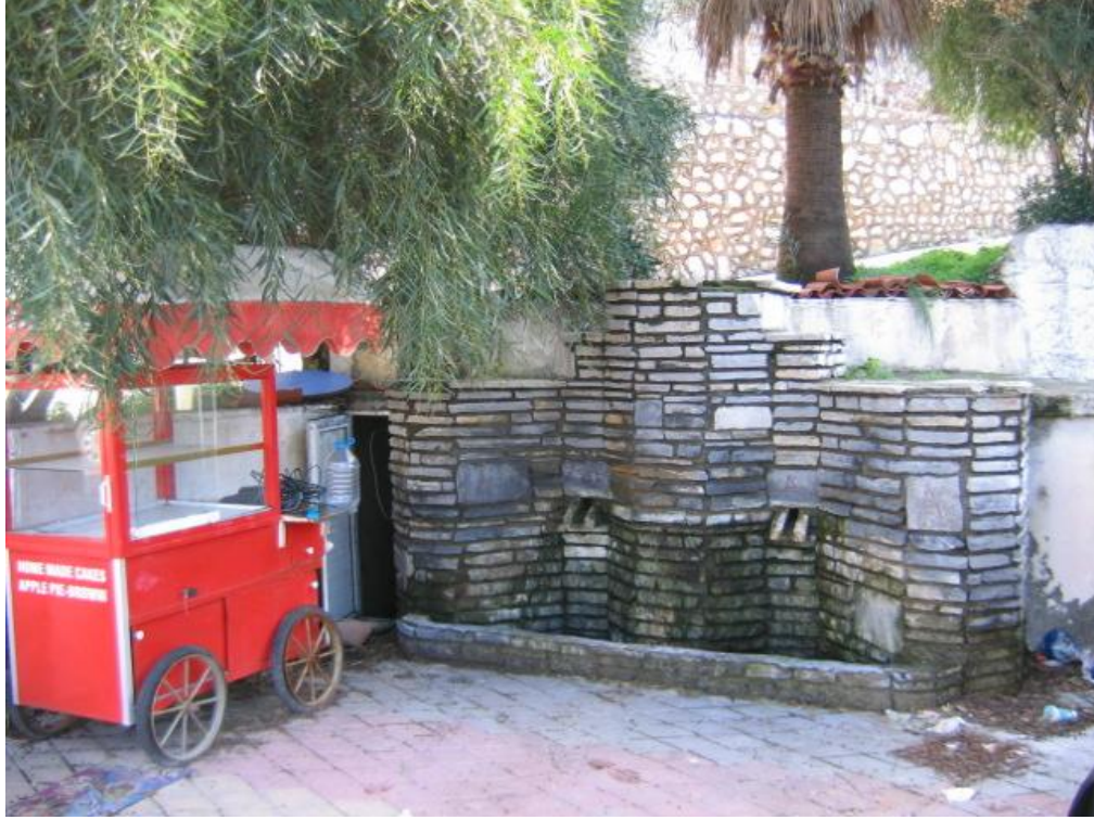
Şekil 4.136 İçmeler kaynağının (MİM-1) dış görünümü.
