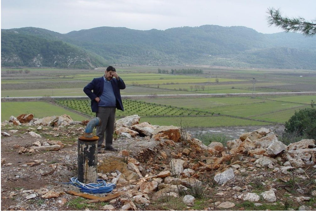
Şekil 4.171 Musalar'da başka bir girişimci mağaranın hemen üzerindeki bir düzlükte bir sondaj kuyu açtırmış muhtemelen aradığı sıcaklık ve/veya debiye ulaşamadığı için sondajı terk etmiştir.
