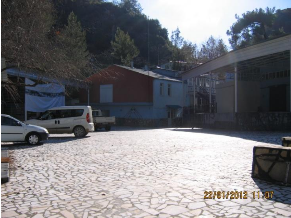
Şekil 4.43 Gökova maden suyu işletmesi tesisleri.
