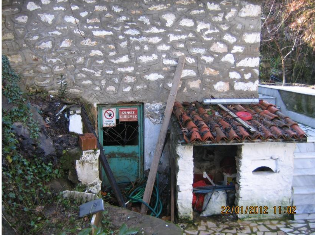
Şekil 4.44 Eskiden termal hamam olarak kullanılan yapı.
