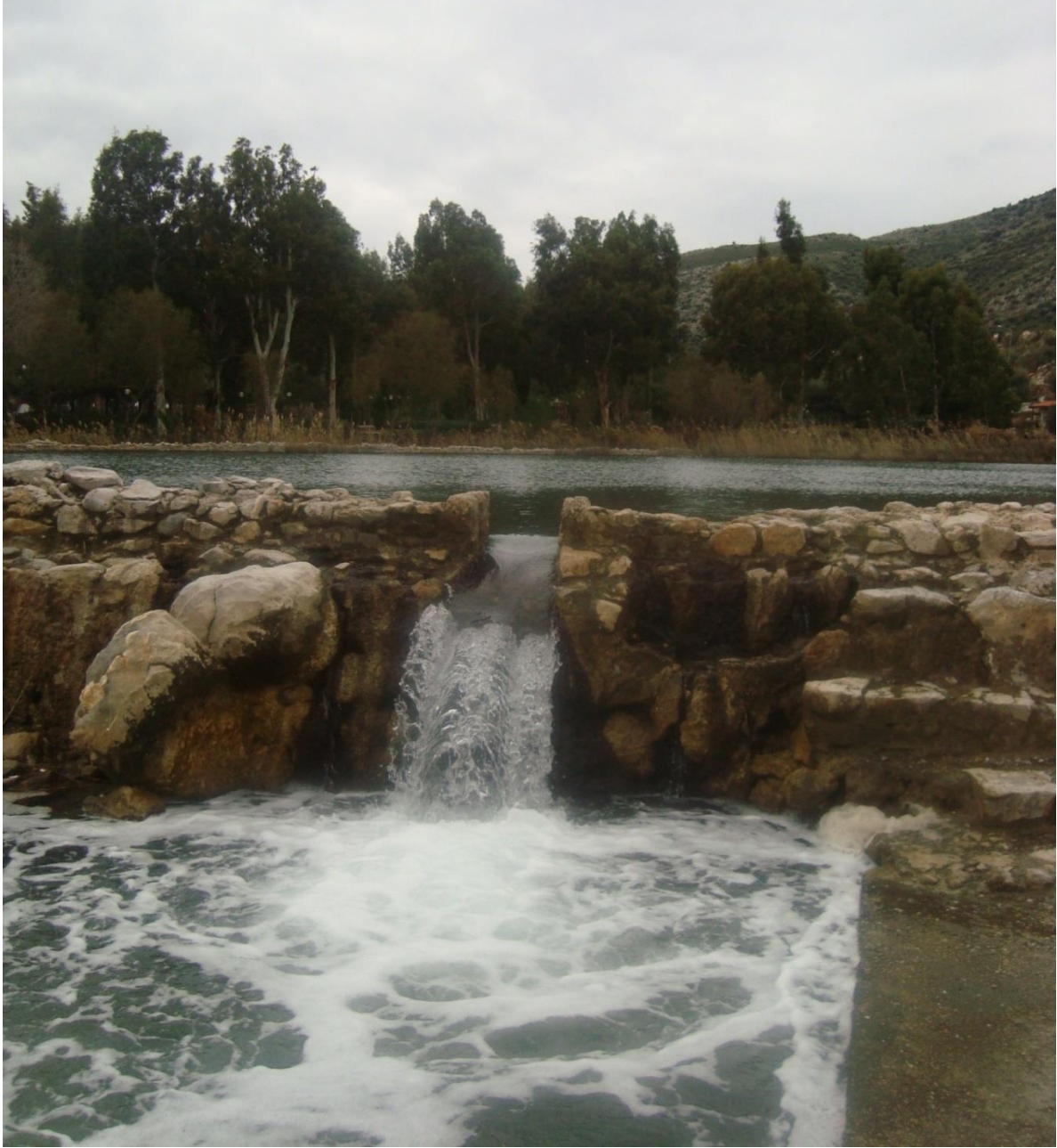
Şekil 4.123 Ilıca DIK-2 örnek lokasyonu. Kaynakların önü bir bentle gerilmiş ve bir oluktan suyun akması için yol verilmiştir.
