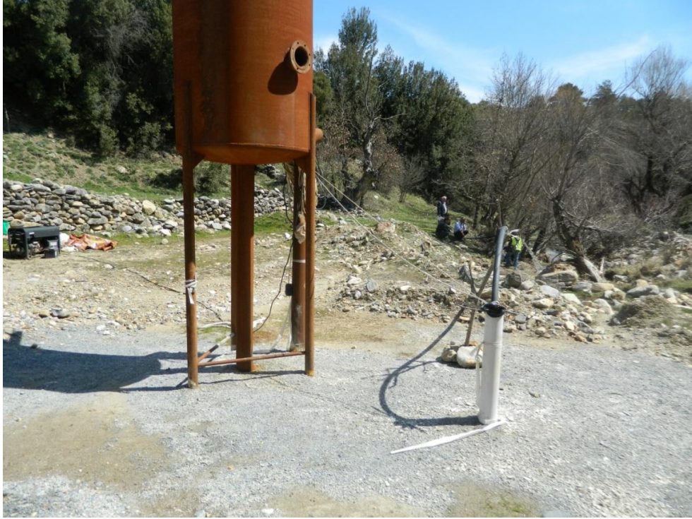
Şekil 4.84 Gaz ve mineralli su üretmek amaçlı açılmış KMK-1 sondajı. Yüksek miktarda gaz ve su çıkışı beklendiği için seperatör kurulmuştur ancak kullanılmamaktadır. Kuyu çalıştırıldığında suyla birlikte kuyu başından gaz gelmektedir.
