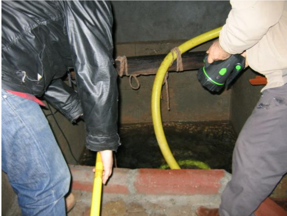
Şekil 4.137 İçmeler kaynağını (MİM-1) korumak için yapılmış yapının içi.
