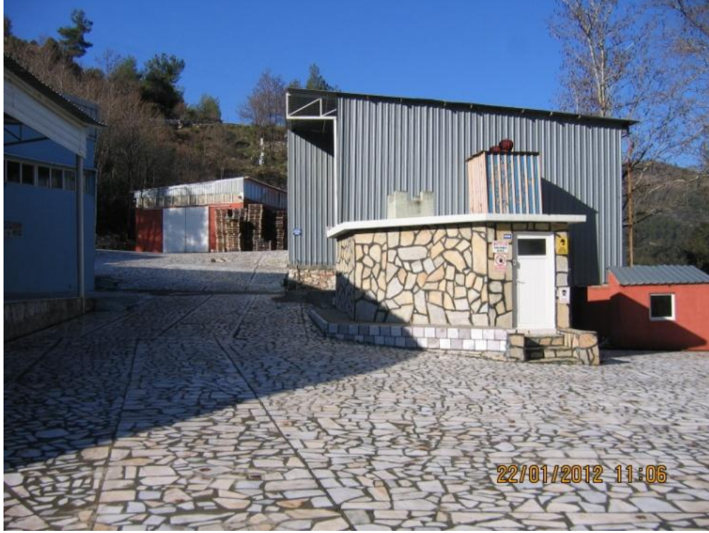
Şekil 4.42 Gökova maden suyu işletmesinin girişi. Sahadaki sondaj kuyusu (YBS-1) beyaz kapılı yapı içindedir.
