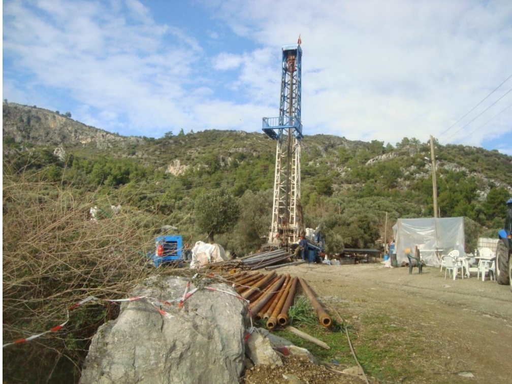
Şekil 4.177 Çürükardı kaynaklarının bulunduğu yerin yaklaşık 250 m güneydoğusunda M.T.A.'nın özel bir sondaj firmasına ihale etmek suretiyle yaptırmakta olduğu sondaj kuyusu şantiyesi.
