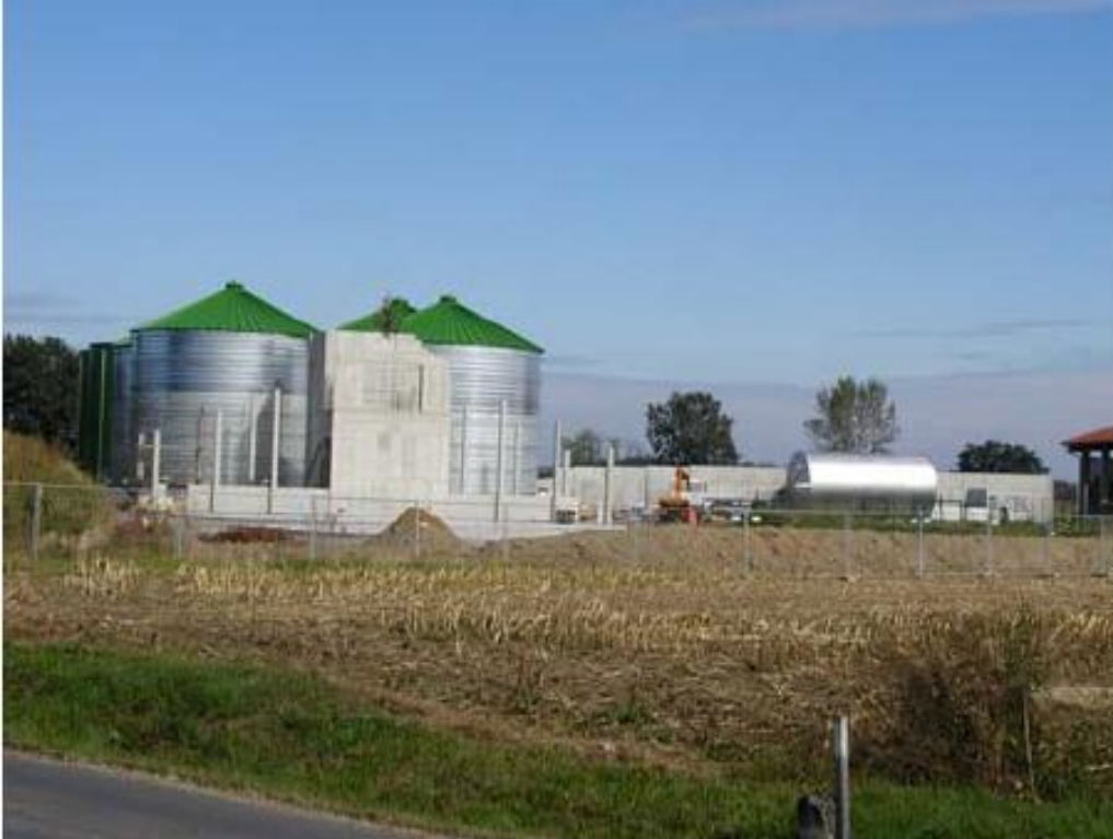
Şekil 2.12. Mureck Biyogaz Tesisi (Puchas, K. and Sakulin, C., 2008).
