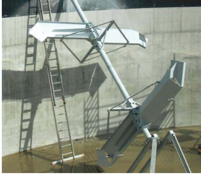
Resim 9: Diyagonal Milli Paletli Karıştırıcı (Tsunami Tip)
