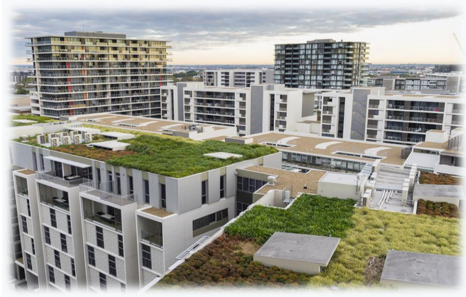
Resim 16: Perlit Kullanılarak Yapılan Bir Yeşil Çatı Uygulaması
