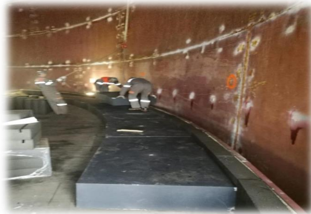
Resim 11: LPG Tankına Perlitli Beton Blok Yerleştirilmesi
