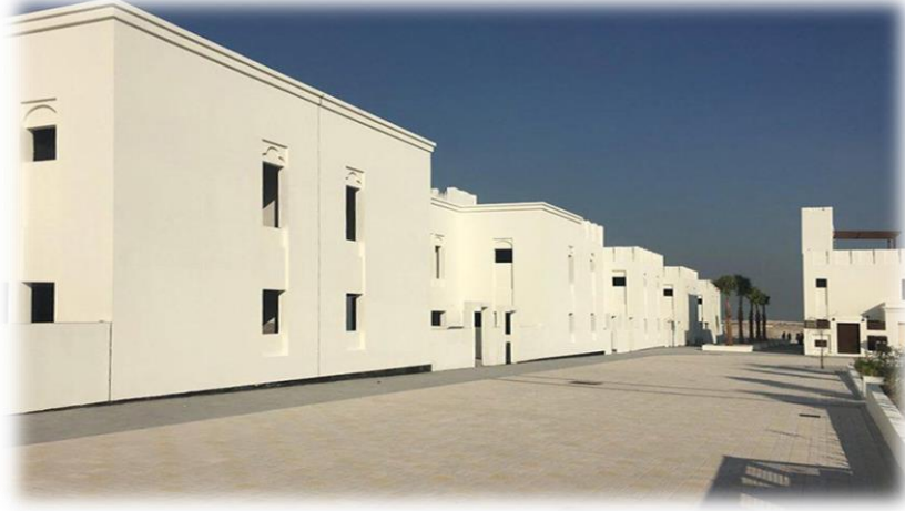
Resim 10: Perlit Esaslı Hafif Yalıtım Sıvası Uygulaması
