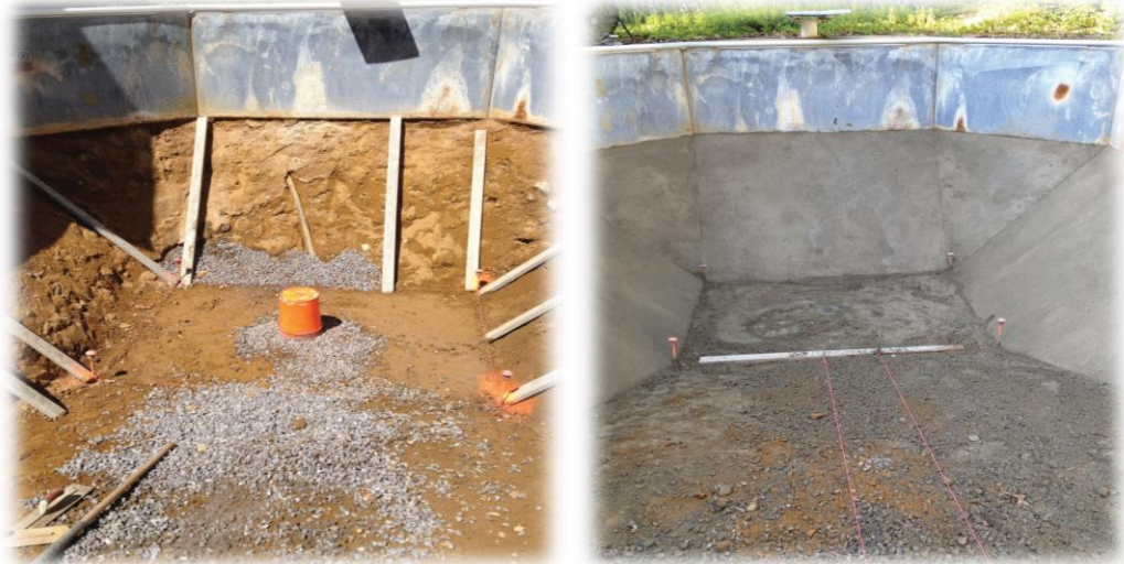
Resim 15: Perlit Betonlu Havuz Tabanı Uygulaması
