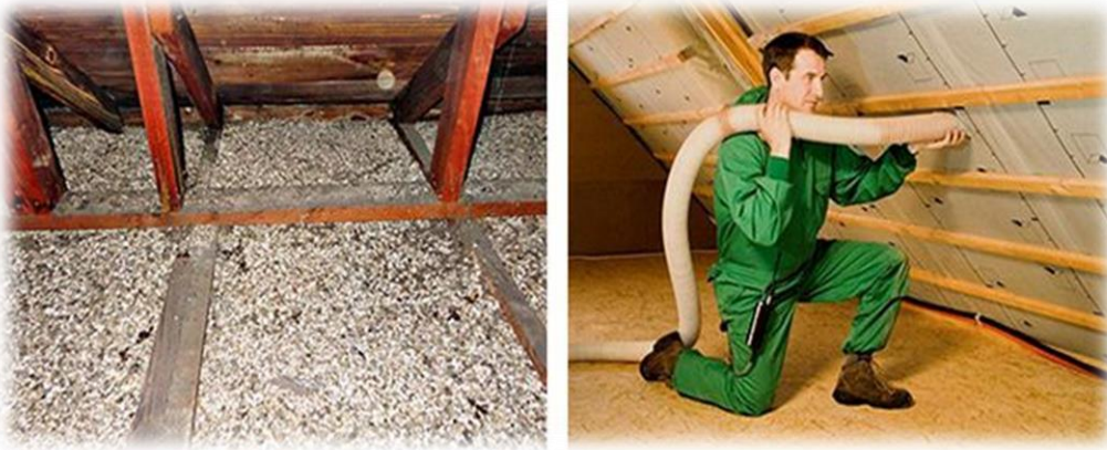
Resim 8: Perlitli Çatı İzolasyonu
