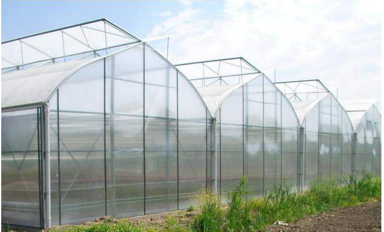
Kelebek Havalandırmalı Gotik Çatılı Yanları Polikarbonat Çatı Plastik Örtülü Sera
