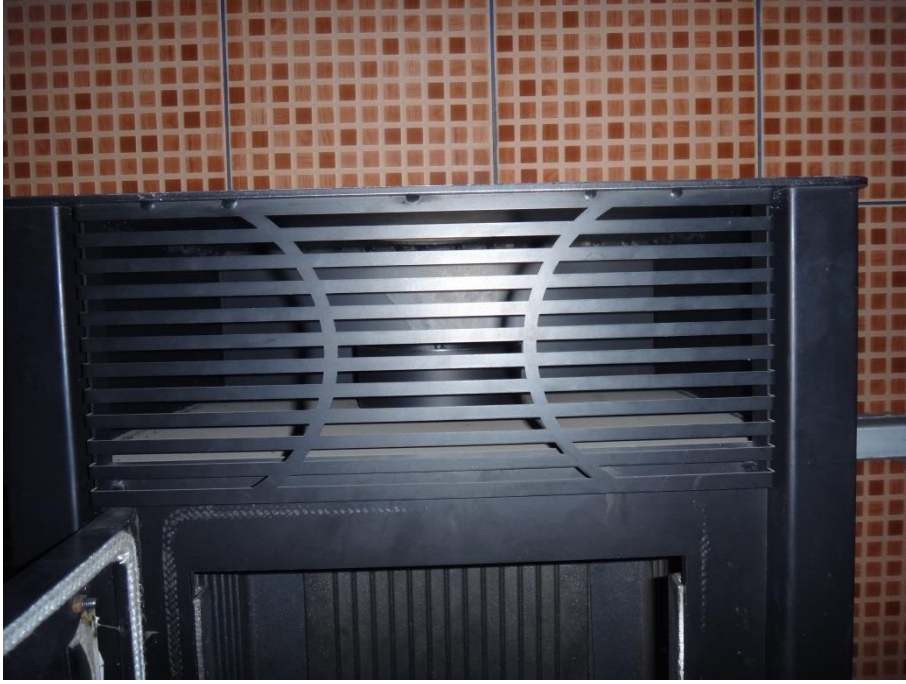
Resim 21 –Şömine, Havayı Önden Aldığı Sonra Yukarı Verdiği Üst Kısmı
