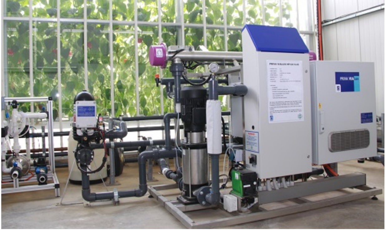
Gübreleme Sistemi
