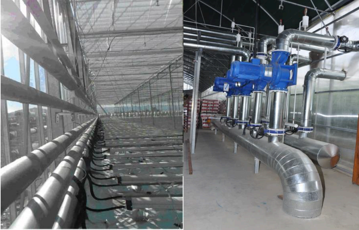
Isıtma sistemi ana hatların görünümü
