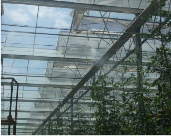
Sisleme sistemi çalışırken görüntüsü
