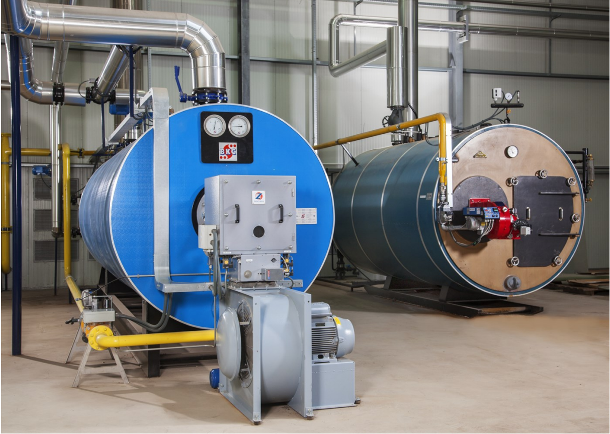
Isıtma kazanı ve kazan dairesi
