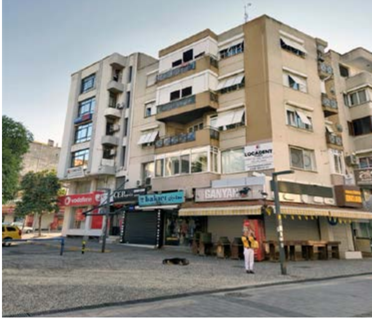
FOTOĞRAF 69. Çarşı Binası Cephe Örneği (Diktaş, Kişisel Arşiv, Mayıs 2024)
