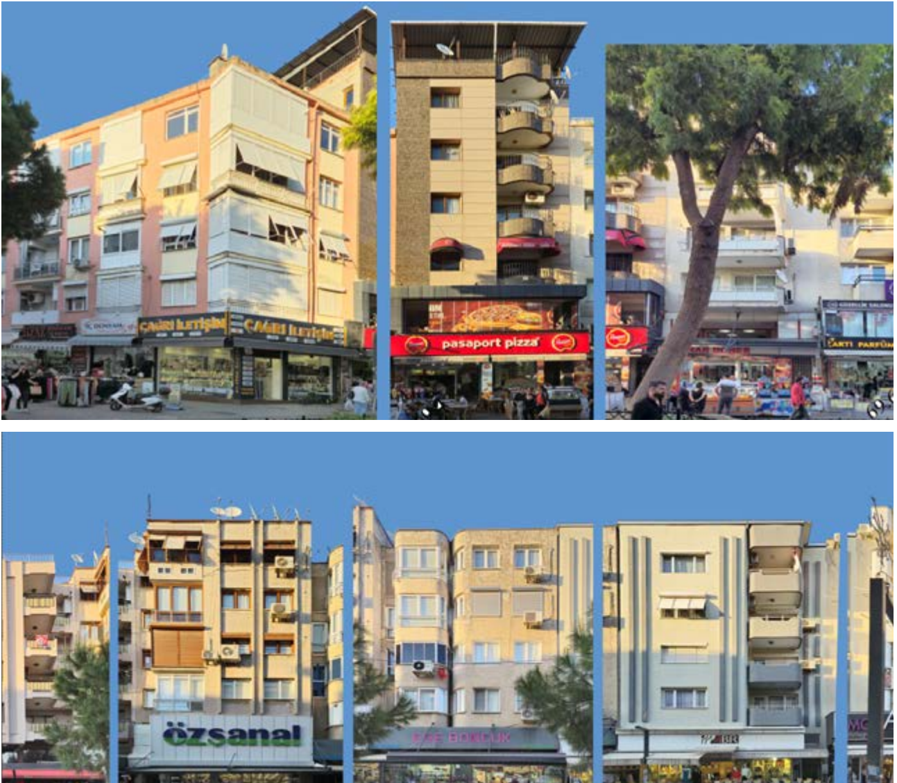
FOTOĞRAF 22. Forbes Caddesi'nde güneye bakan yapılarda gün ışığı kontrolü için yapılan uygulamalar (Diktaş, Kişisel Arşiv, Mayıs 2025)
