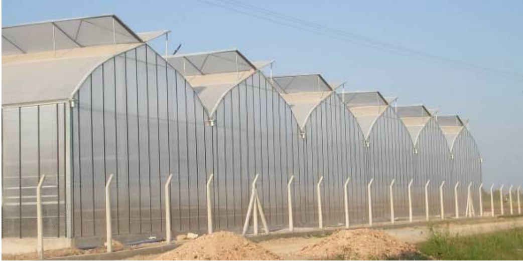
Şekil 7. Sera çatı görüntüsü
