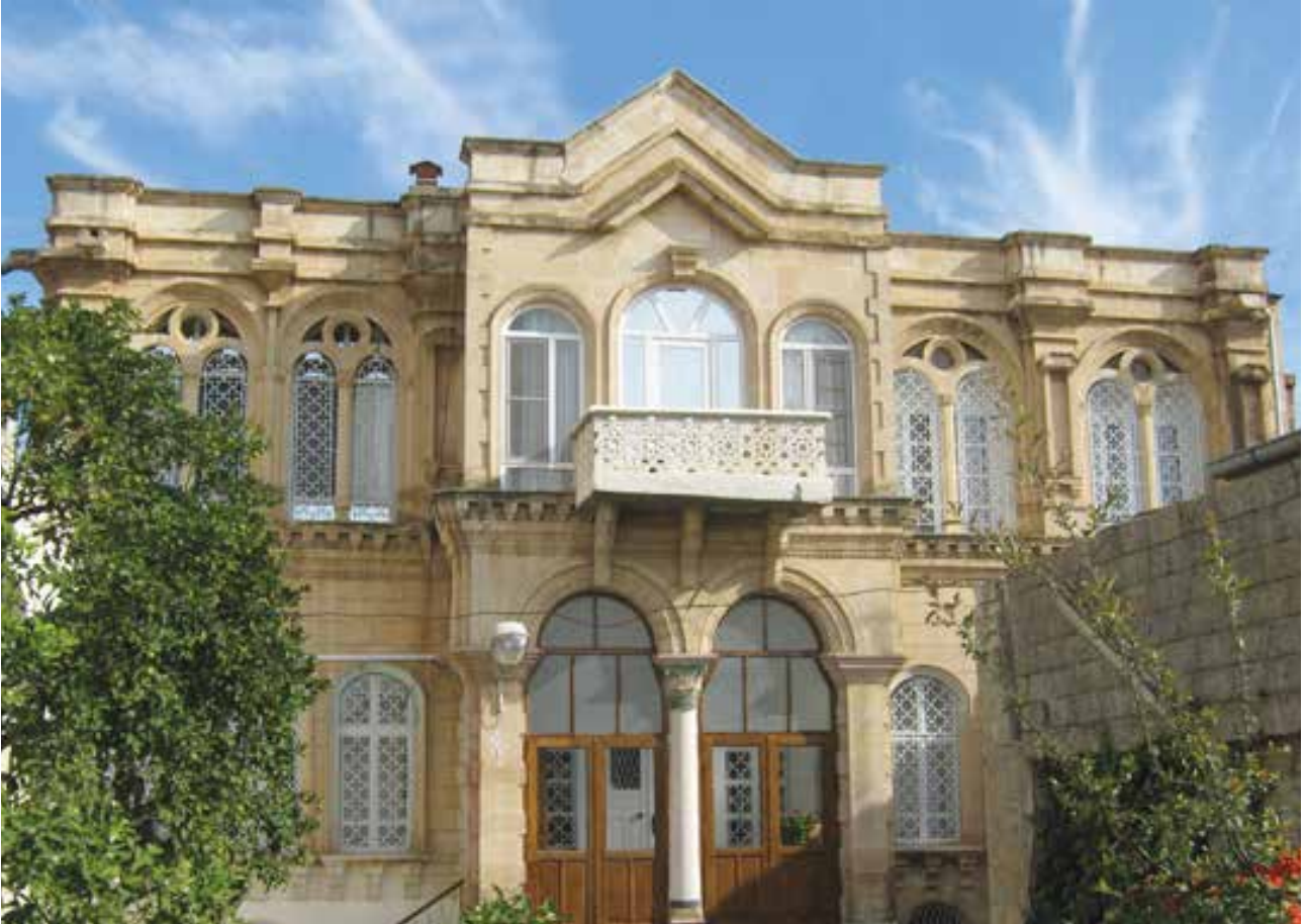
Akıncı Konağı, Kilis
