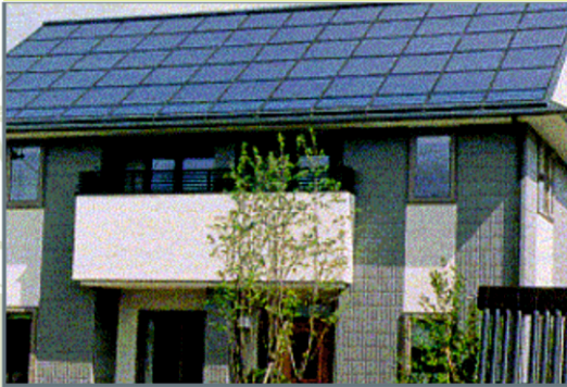
ŞEKİL.6 ÇATISI GÜNEŞ PİLİ İLE KAPLI EV
