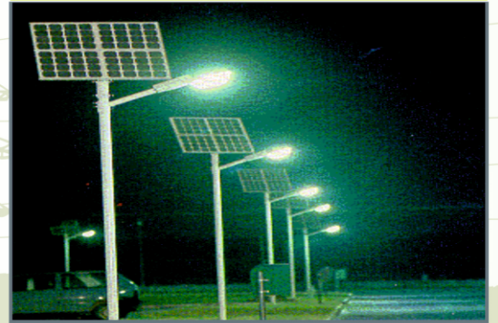
ŞEKİL.7 GÜNEŞ PİLLERİ İLE SOKAK AYDINLATMASI
