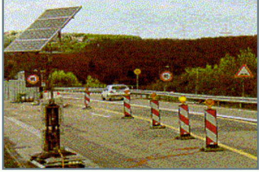
ŞEKİL.9 GÜNEŞ PİLLERİNİN KARAYOLLARINDA KULLANIMI
