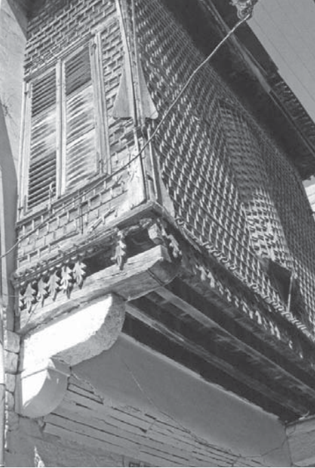
Şekil 41. Kilis Mimarisi Çörtlen ve Cumba Detayı
