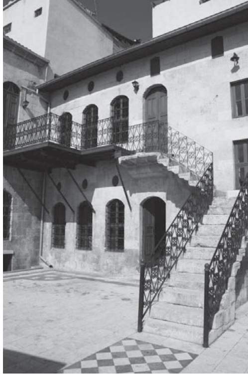
Şekil 37. Açık Merdiven ve Koridor Örneği, Hüseyin Enç Evi, Türktepe, Gaziantep
