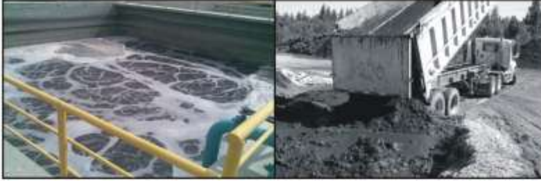
Şekil 11 Arıtma Çamurlarının Düzenli Depolanması
